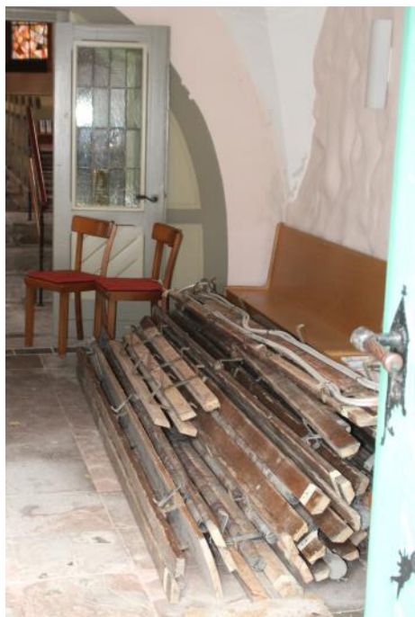
Die demontierten Fußbänke mit den Heizungsrohren
